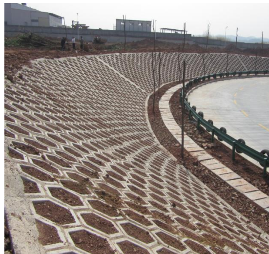
图 10: 道路边坡防护 (2016.12)
