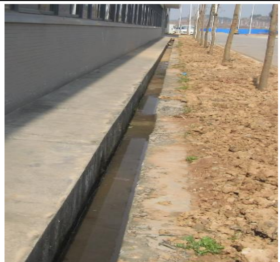
图 6: 主体建筑区排水沟 (2017.3)
