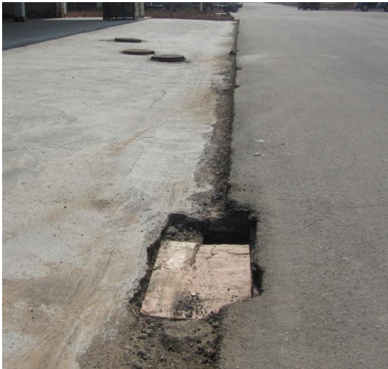
图 7: 排水管网、检查井 (2017.3)
