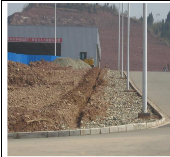
图 1: 开挖临时排水沟 (2016.12)
