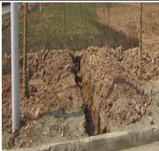
图 5: 开挖临时排水沟 (2017.3)
