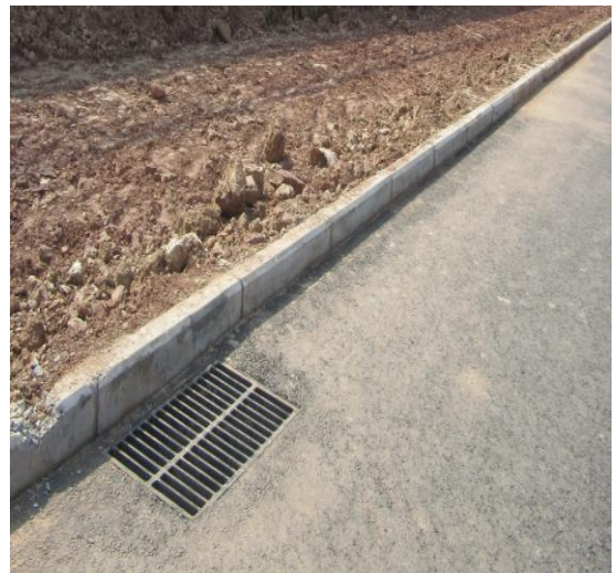
图 4: 道路广场排水沟 (2016.12)
