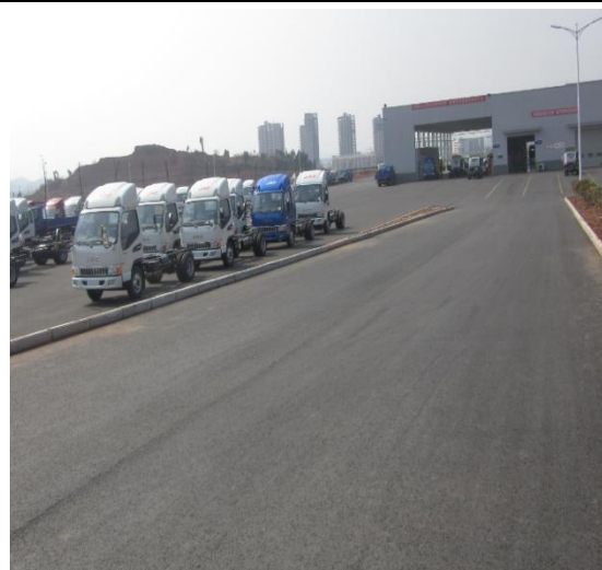
图 12: 道路广场及停车场区硬化 (2017.3)
